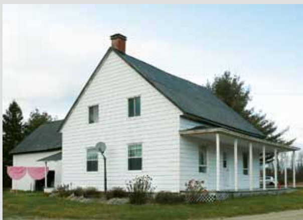
Maison revêtue d'un parement d'aluminium.
