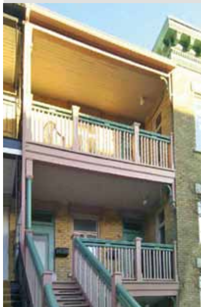
Exemples de garde-corps anciens rehaussés par le haut ou par le bas afin de les adapter aux nouvelles réglementations en vigueur.
