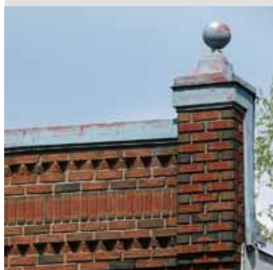
Variété de couronnements et de parapets en brique et en tôle.
