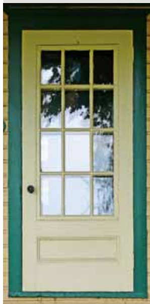
Porte en bois de modèle traditionnel à panneaux avec vitrage à petits carreaux.
