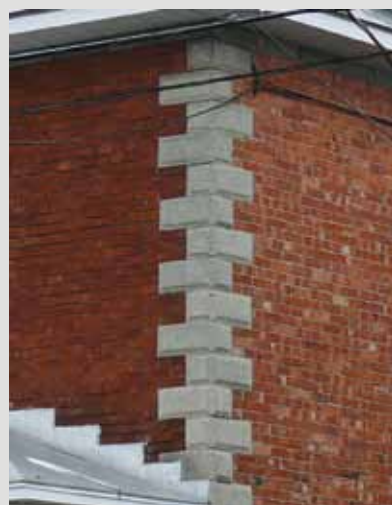
Chaînage d'angle en pierre artificielle à la jonction de deux murs de briques.
