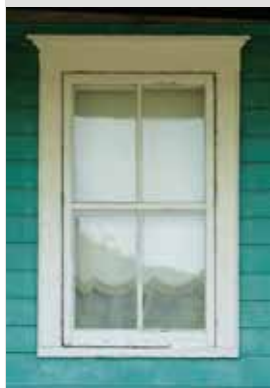
Fenêtre à guillotine à grands carreaux.
