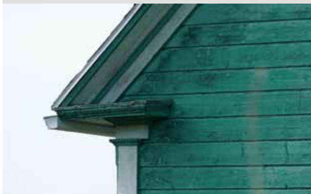
Retour de corniche ornant l'angle d'une maison
