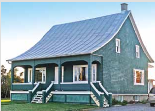
Maison traditionnelle munie d'une galerie protégée par le prolongement (appelé larmier) du toit.
