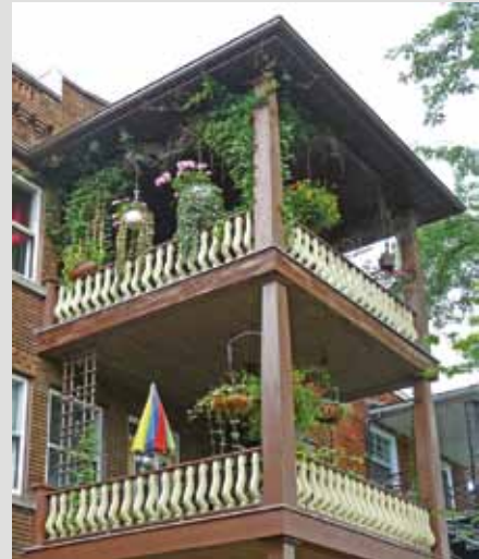
Balcon en forte projection
