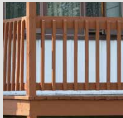
Éviter les garde-corps préfabriqués avec les barreaux fixés aux flancs de la main courante et de la lisse basse.
