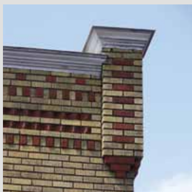
Variété de couronnements et de parapets en brique et en tôle.
