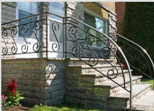
Garde-corps en fer ornamental.
