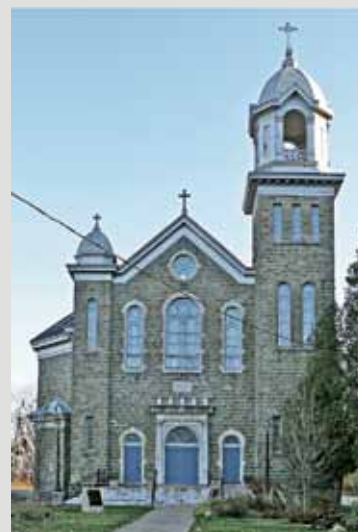
Église de Notre-Dame-de-la-Présentation, 825, 2 e Avenue, secteur Shawinigan-Sud.
