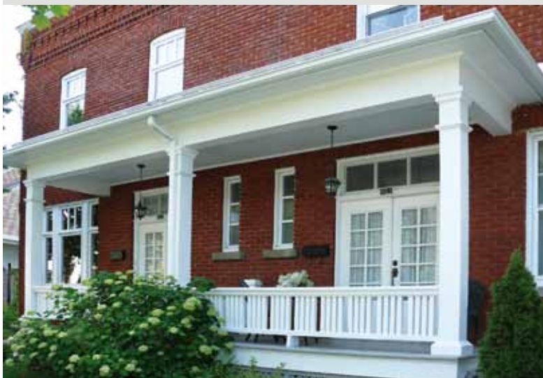
La galerie de cette maison jumelée protège adéquatement les entrées.
