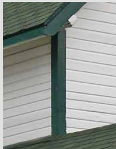
Planche cornière en bois sur laquelle les planches à feuillures viennent s'appuyer.
