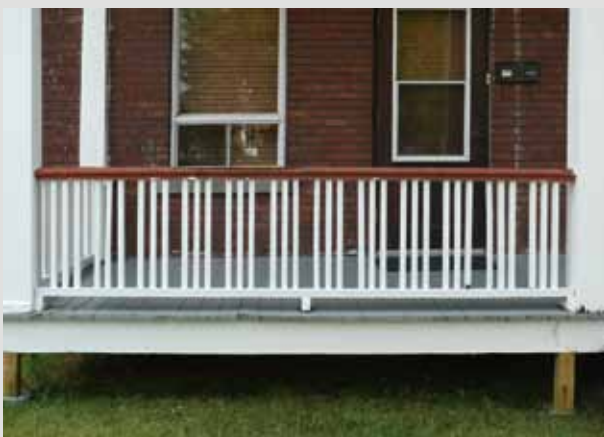
Garde-corps en bois de facture simple.
