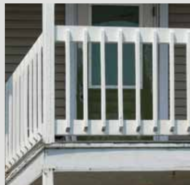
Éviter les garde-corps préfabriqués avec les barreaux fixés aux flancs de la main courante et de la lisse basse.
