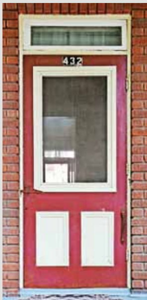
Porte en bois à panneaux avec grand vitrage et munie d'une imposte vitrée.
