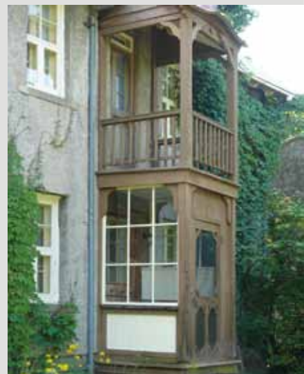
Ce balcon superposé à un tambour a conservé ses éléments en bois.
